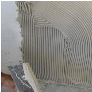
Rake the mortar.
